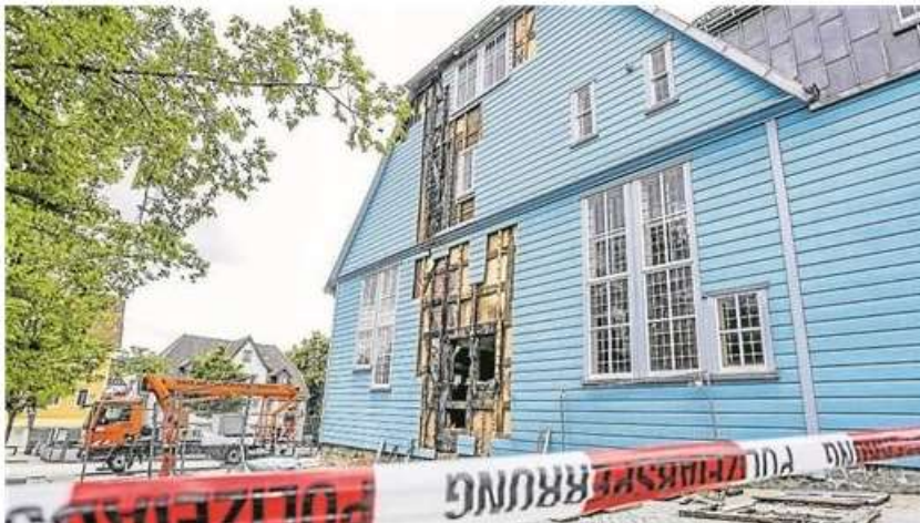
Nach dem Brand an der Fassade der Marktkirche wird der Bereich von der Polizei für die Ermittlungen und weitere Untersuchungen abgesperrt.
